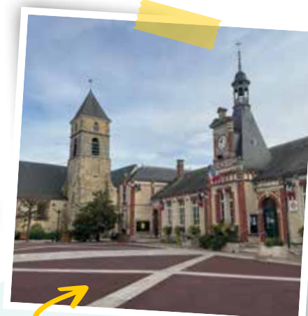
Rénovation de la place de la Mairie
