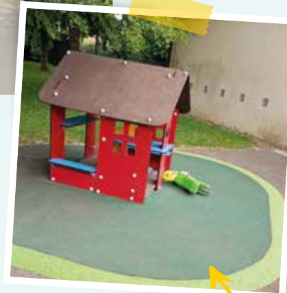
Rénovation des sols amortissants des aires de jeux de la crèche
