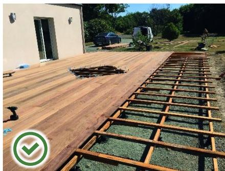
Terrasse en bois sur plot et lambourde permettant l'infiltration des eaux pluviales
