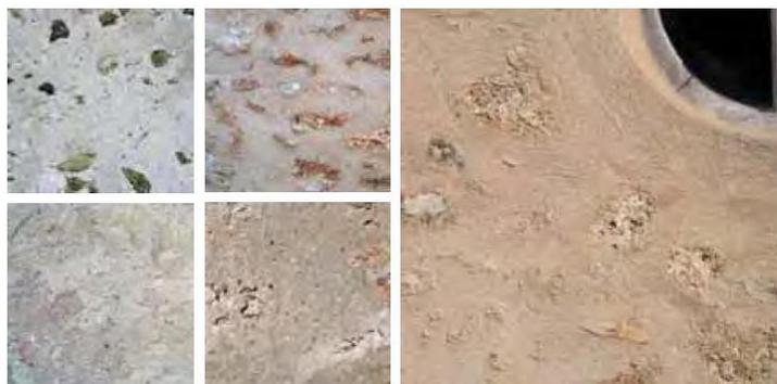
**Les enduits « à pierre vue »** affleurent le nu extérieur des pierres. Ainsi les tons jaunes, orangés ou gris des pierres s'associent-ils aux tons blonds de l'enduit constitué de chaux et de sable de Fontainebleau.
