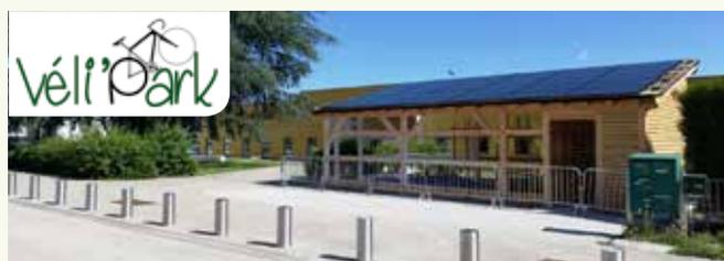
Le projet de cet abri se veut écologique et esthétique. Il est fabriqué en ossature bois et revêtu d'un bardage métallique. À terme, les 2 abris seront équipés d'un système de vidéo protection et de panneaux photovoltaïques sur leur toiture, permettant l'autonomie dans la production d'une électricité propre et locale pour la recharge des vélos à assistance électrique.
