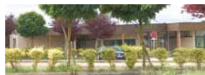
COIE (Centre Omnisports Intercommunal) Rue du chemin vert
